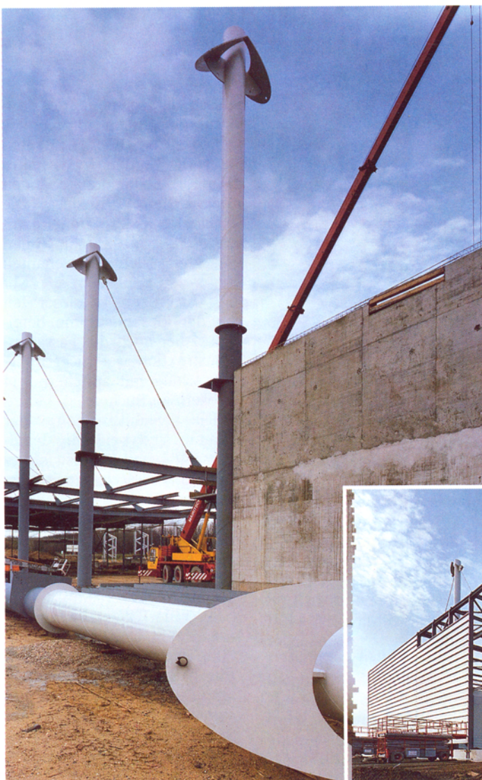
Abb. 2: Die Stahlpylone, die markantesten Konstruktionselemente des Gebäudes, werden aufgestellt.
