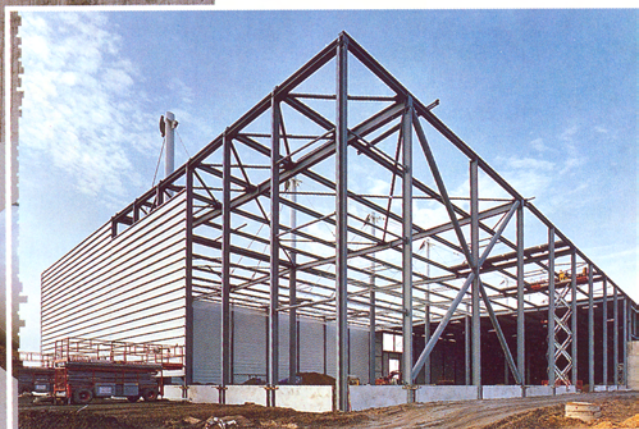
Abb. 3: Das Tragwerk steht und die Stahlkassettensprofile können montiert werden. Der Dämmstoff ist noch nicht eingebaut.
